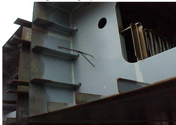
(d) Erection joint area without using masking tape
